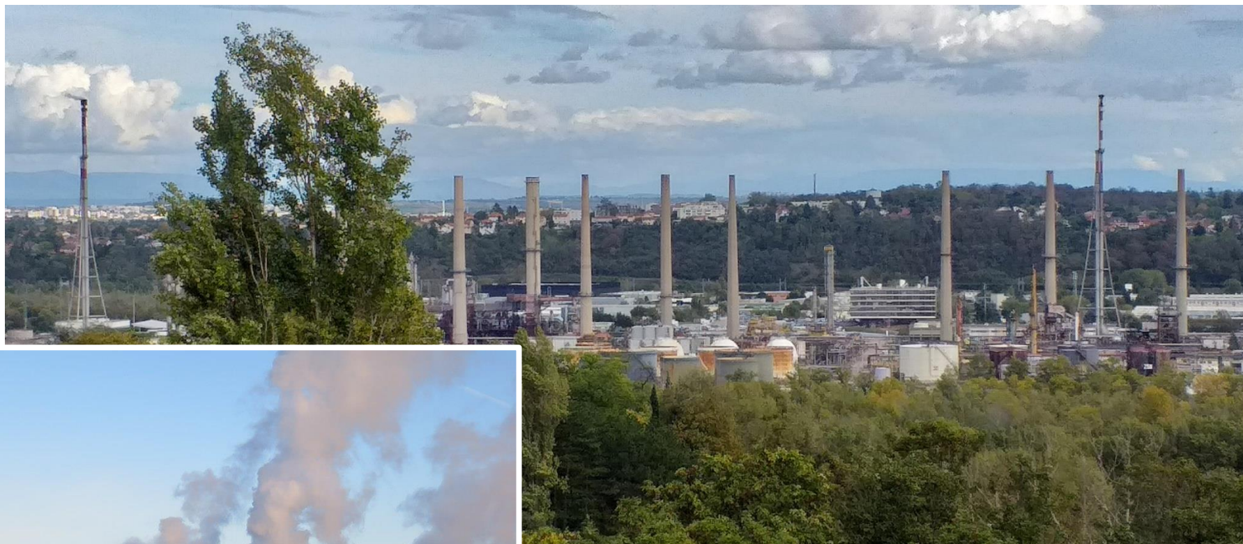
Feyzin au sud de Lyon: Vallée de la chimie (cliché © Beynet, 2023)
