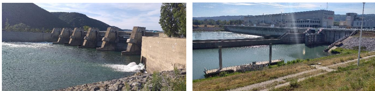
Fig. 2 : À gauche, barrage de La Roche-de-Glun, à droite, usine hydroélectrique et écluse grand gabarit de Bourg-Les Valence (clichés © Beynet, 2023)
